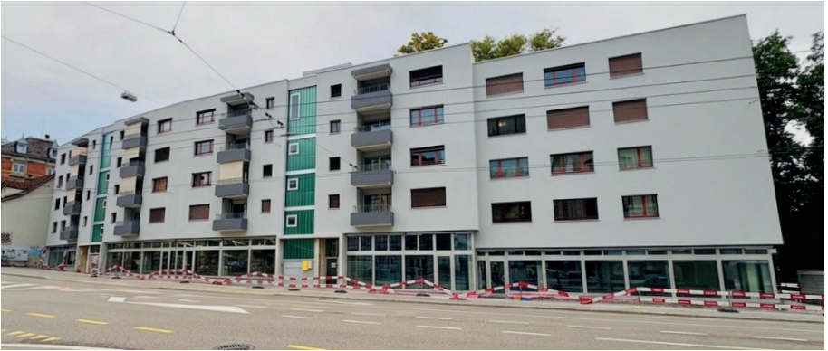
Rorschacherstrasse, St. Gallen
