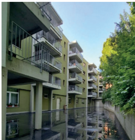
Rorschacherstrasse, St. Gallen
